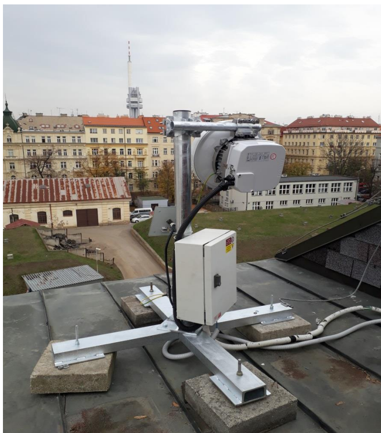
Foto č. 1 – Lokalita Dykova - montáž antény, zátěžového stožáru a ODU
