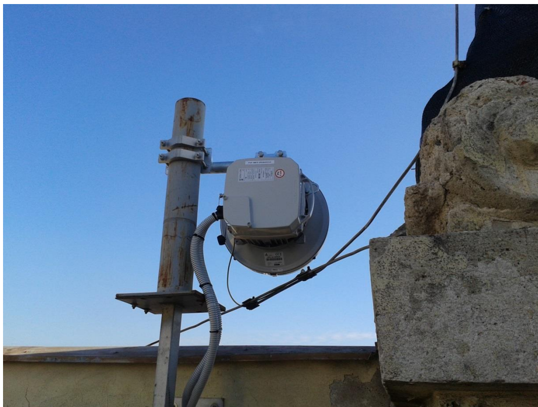
Foto č. 1 – Lokalita Korunní – montáž antény a ODU
