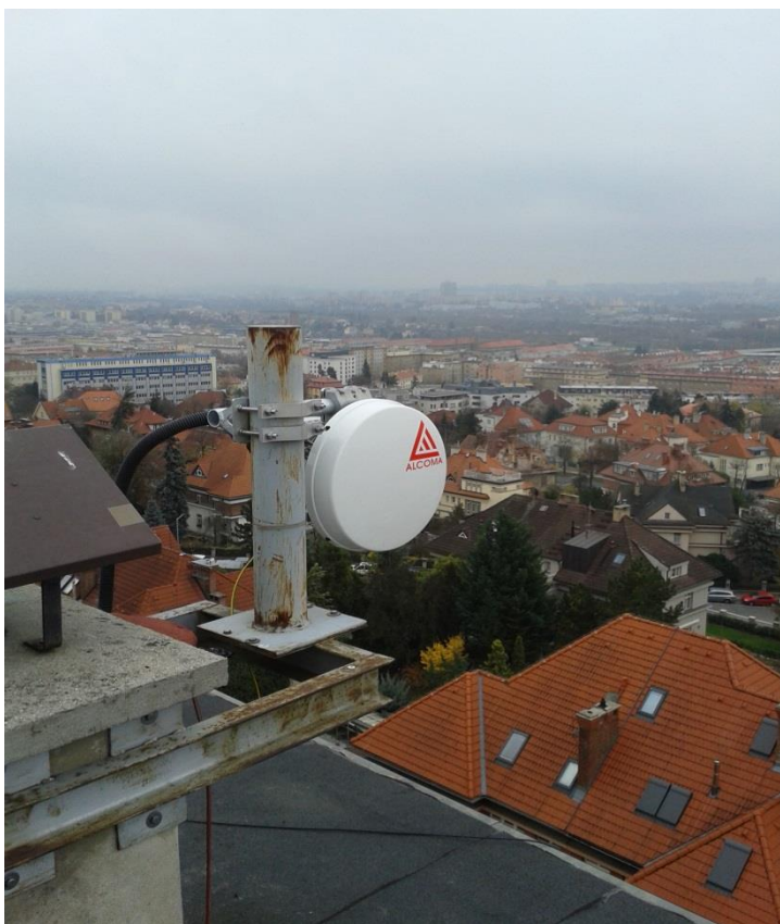
Foto č. 4 – Lokalita Šrobárova – montáž antény a ODU
