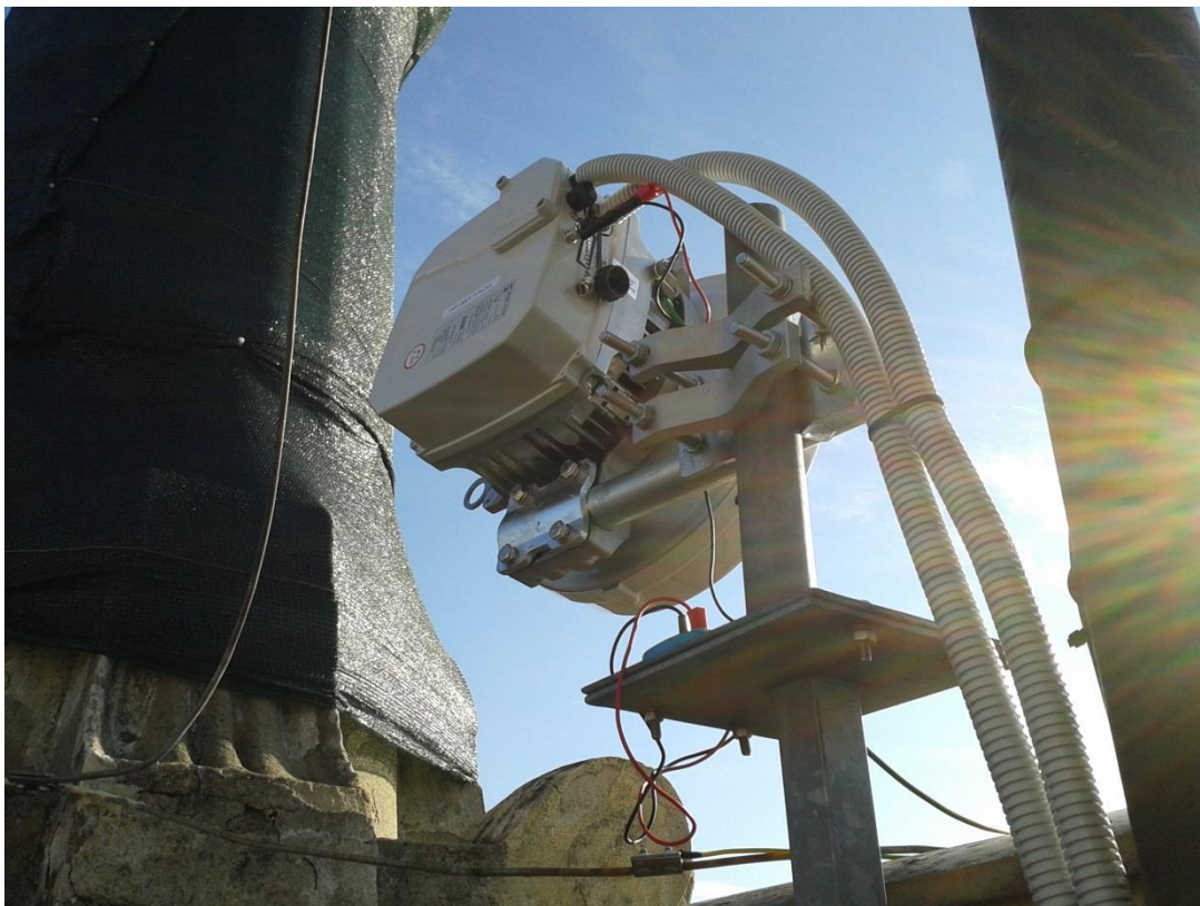
Foto č. 3 – Lokalita Korunní – montáž antény a ODU
