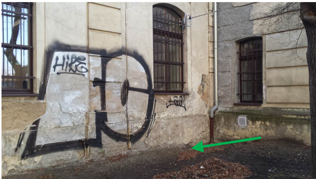
Obrázek 8: Okapový chodníček chybí, navršená zemina spadáje k objektu.
