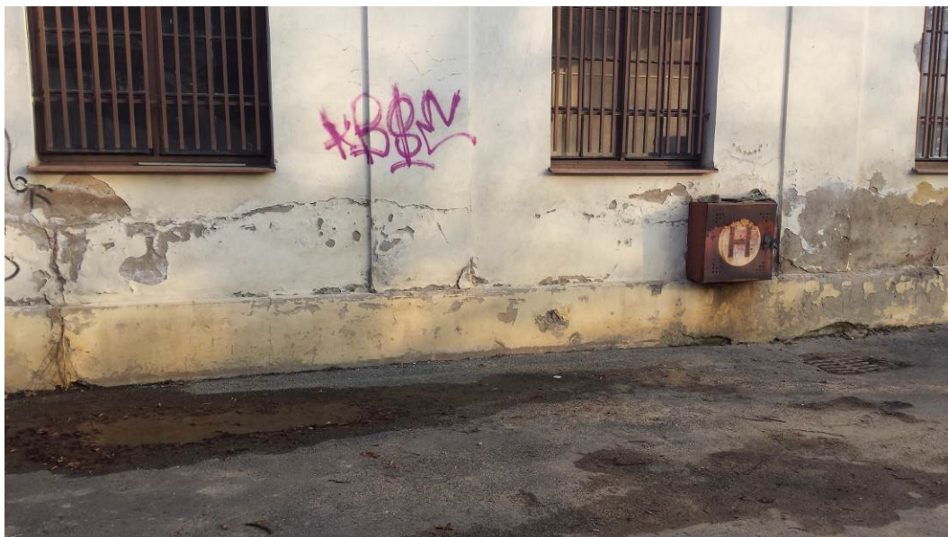
Obrázek 3: U objektu se drží kaluže dešťové vody – západní průčelí.
