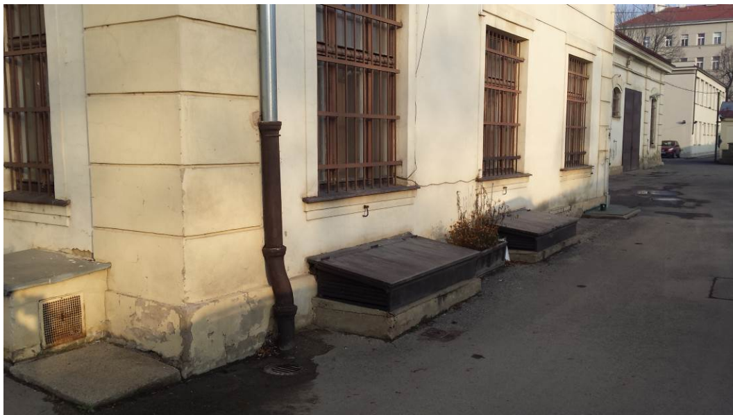
Obrázek 4: U objektu se drží kaluže dešťové vody – jihozápadní nároží rizalitu.
