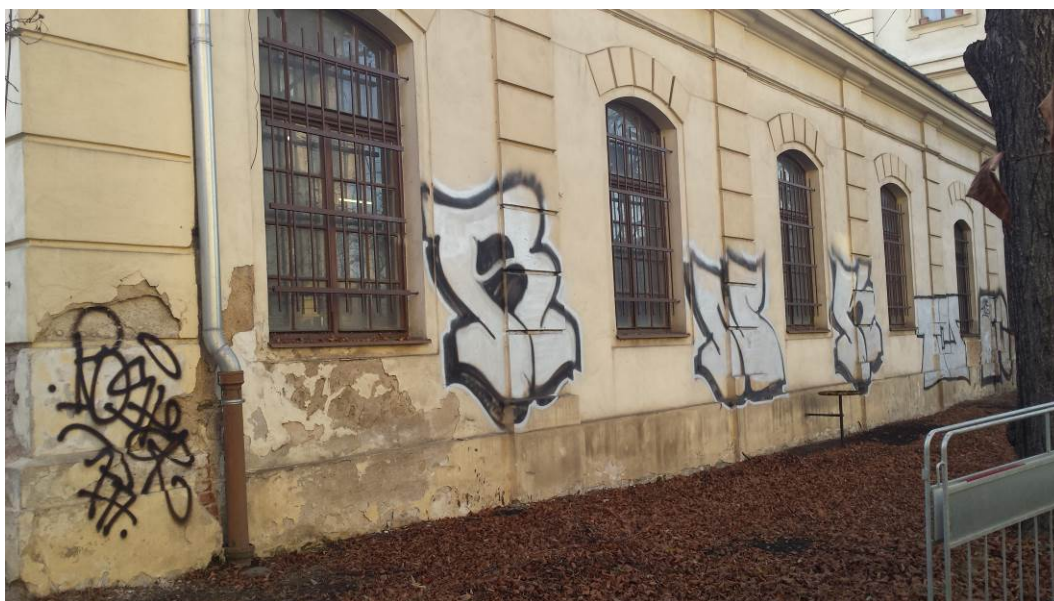
Obrázek 8: Okapový chodníček chybí, zemina sahá až k fasádě.
